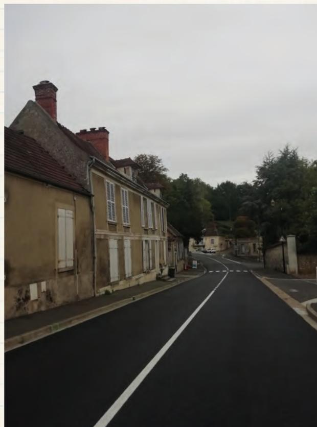
Suite aux travaux d'eaux usées, d'eau potable, travaux d'enfouissement des réseaux, réfections de trottoirs et afin de terminer ce quartier, le Conseil Départemental a réalisé la reprise de la couche de roulement.
