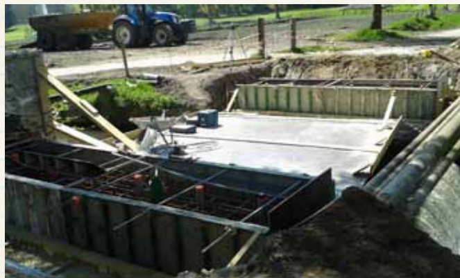
Préparation des appuis : coffrage ferrailage
