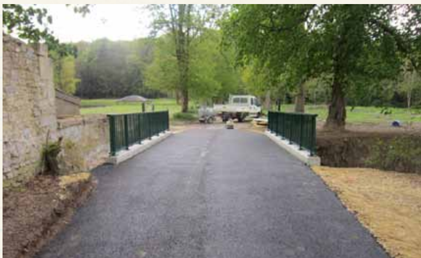
Ouvrage sur la Troësne
