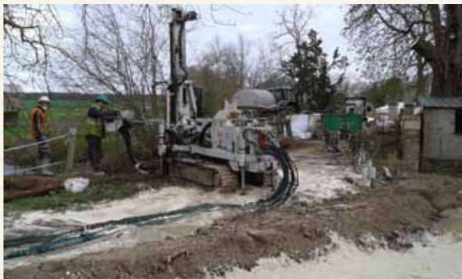
Ouvrage sur la Troëne : mise en place de micro-pieux
