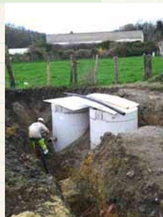
Extension des réseaux d'eau potable et d'assainissement. Pose de canalisations en grès et poste de refoulement.
