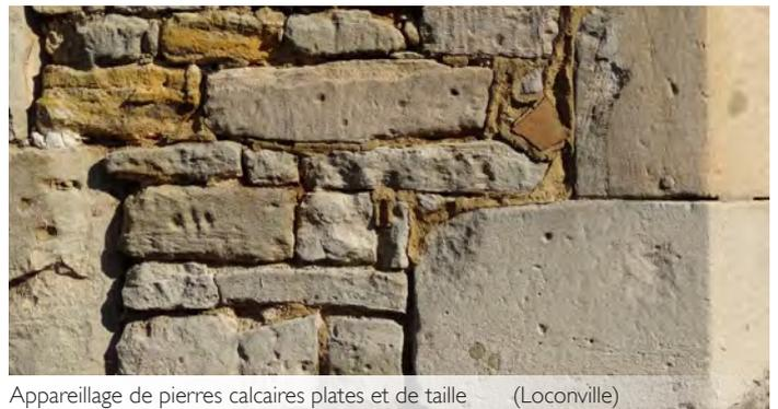
Appareillage de pierres calcaires plates et de taille (Loconville)
