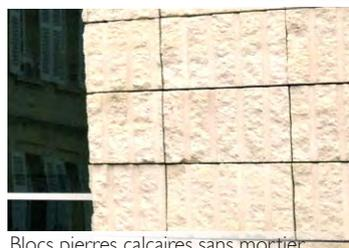
Blocs pierres calcaires sans mortier
